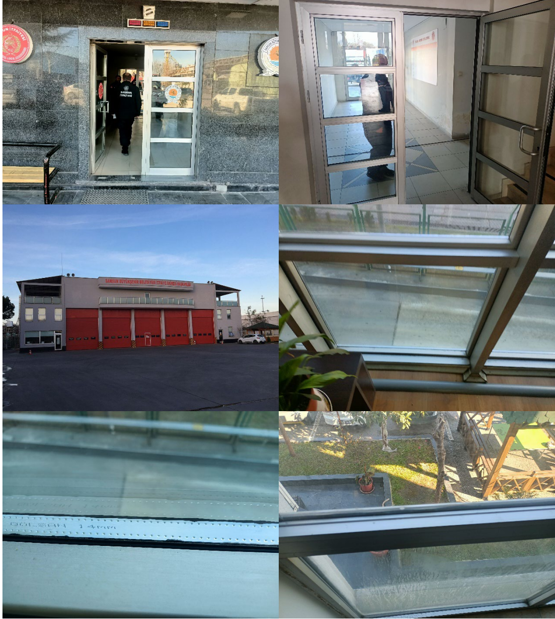
Resim 4.3-1 Bina Kapı ve Pencere Genel Görünümü
