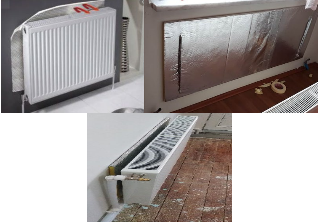
Resim 5.3-4 Radyatör arkası temsili yalıtım levhası uygulamaları
