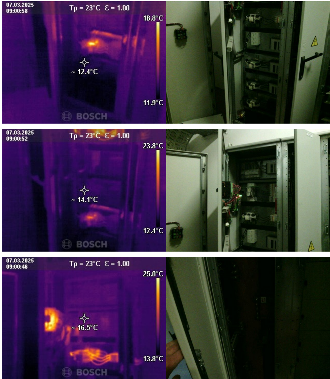
Resim 6.2-2 Kompanzasyon Panosu Termal Görüntüsü
