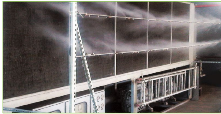
Resim 5.2-4 Evaporatif Ön Soğutma Sisteminde Giriş Havaasının Soğutulması
