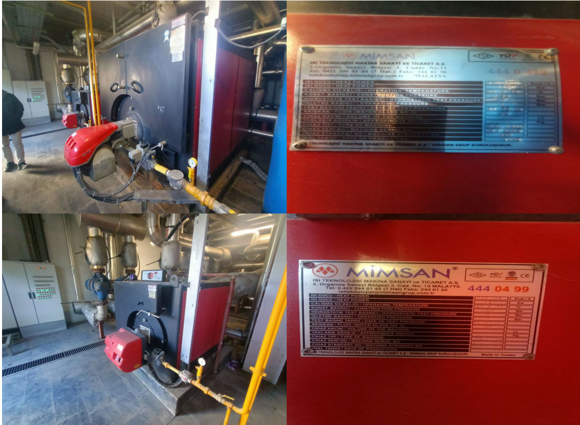
Resim 5.1-1 Çelik Kazan Genel Görüntüsü
