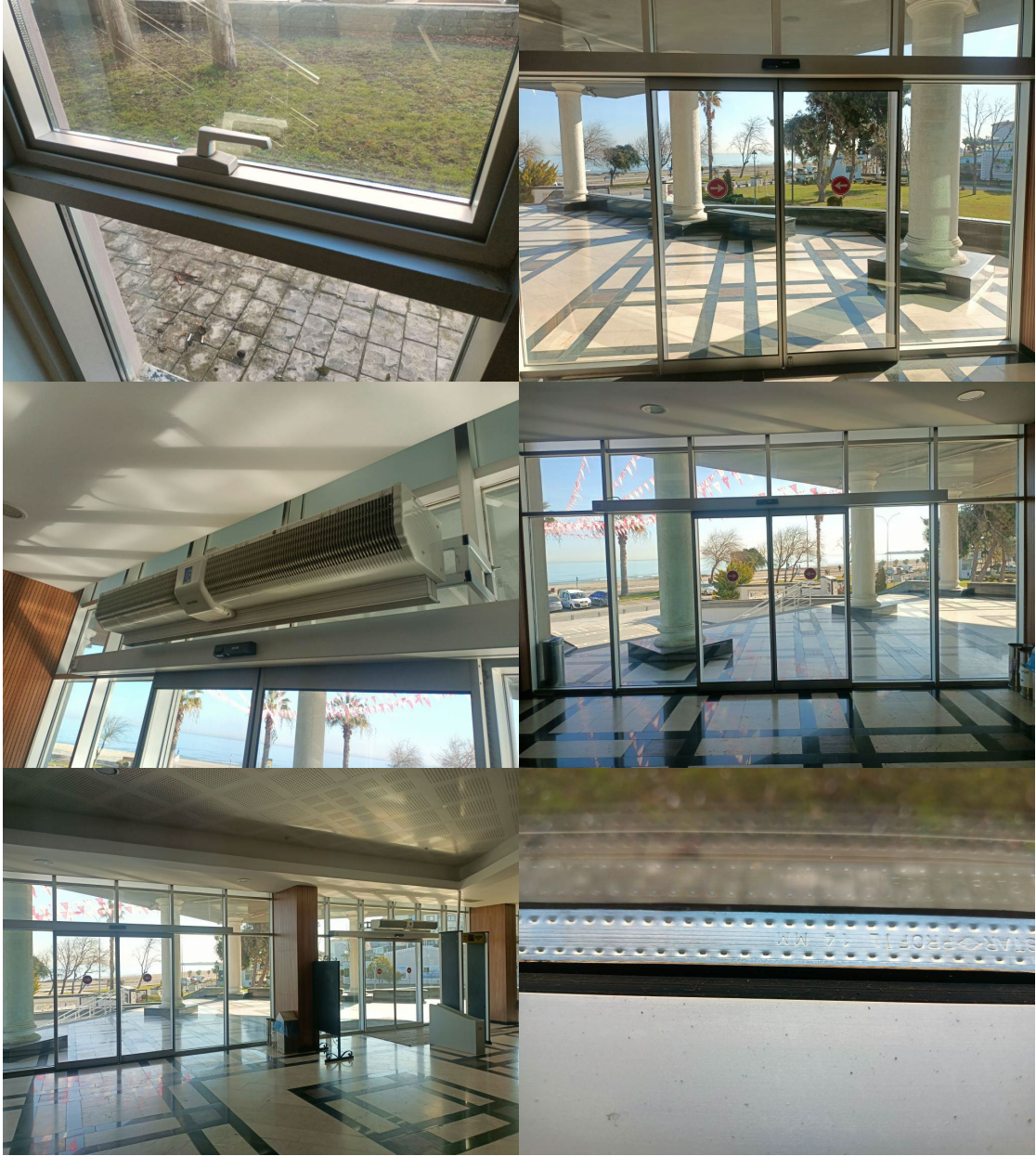
Resim 4.3-1 Bina Kapı ve Pencere Genel Görünümü
