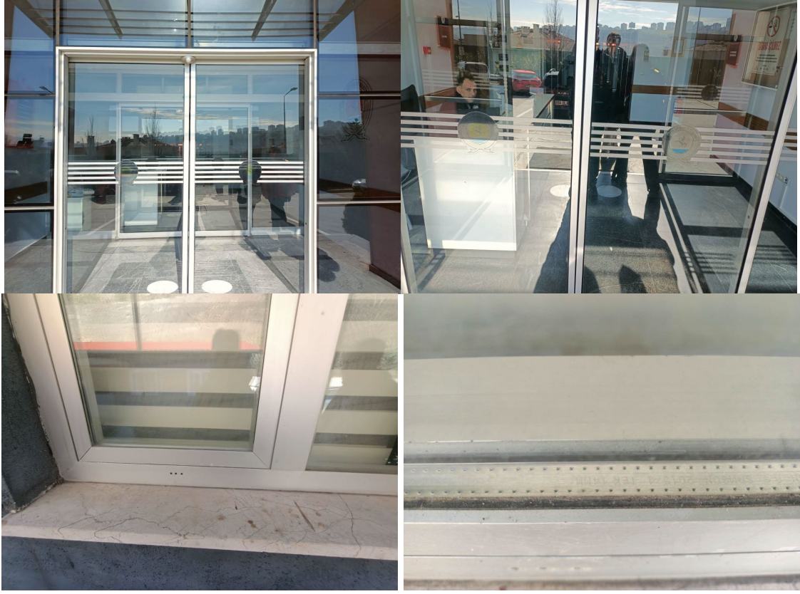
Resim 4.3-1 Bina Kapı ve Pencere Genel Görünümü
