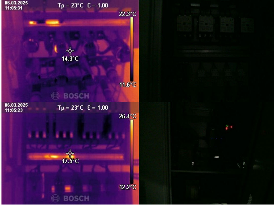
Resim 6.2-2 Kompanzasyon Panosu Termal Görüntüsü
